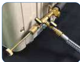
Extracción de mecanismo
