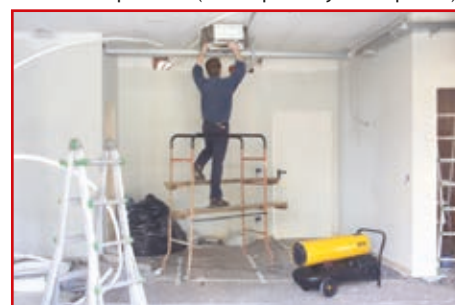
Secado de obras
